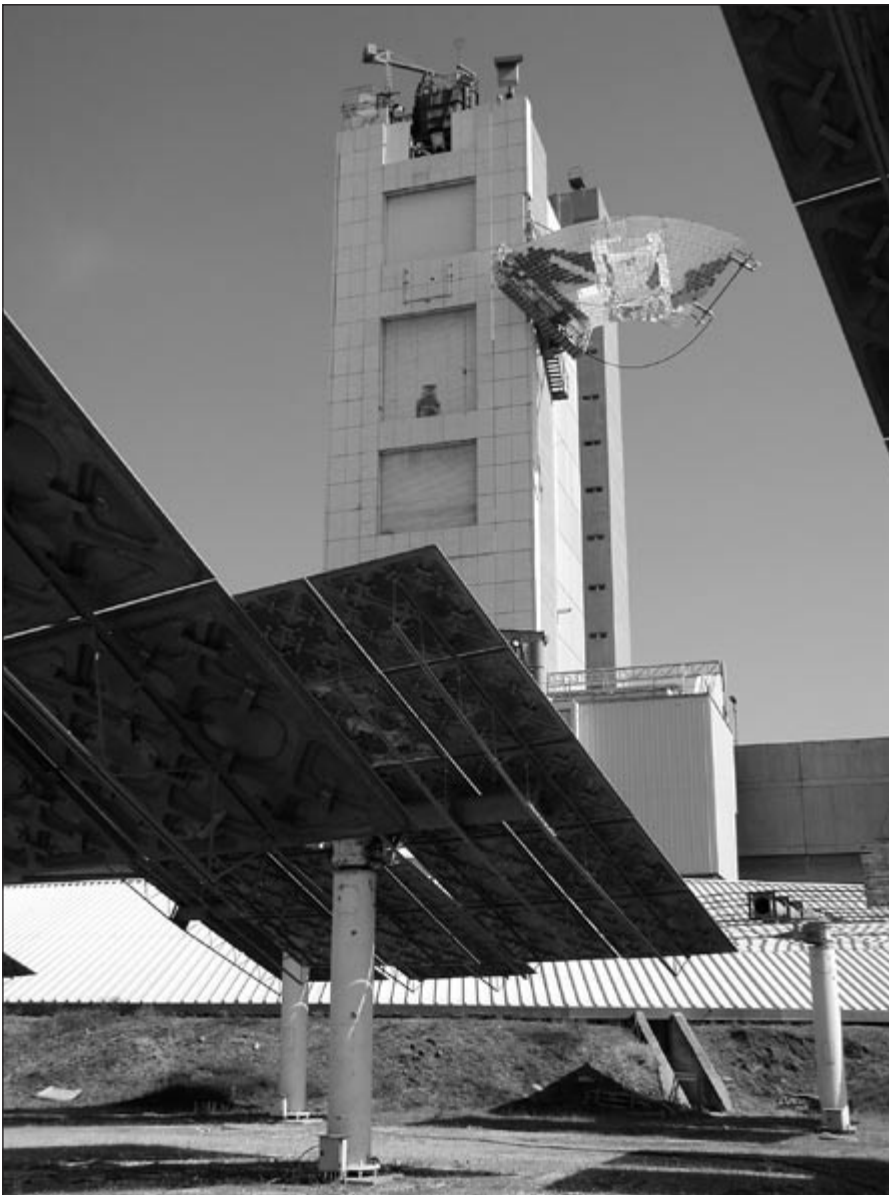
Abb. 6: Die Solaranlage am Weizmann Institute of Science in Rehovot/Israel. Blick aus dem Spiegelfeld (bestehend aus insgesamt 64 Heliostaten mit je 56 \text{ m}^2 Fläche) auf den 54 m hohen Turm. Während für viele Projekte eine der Experimentierplattformen im Turm verwendet wird (man erkennt die Öffnungsmöglichkeiten an der Seite des Turmes), nutzt man für SOLZINC die Beam-down-Installation: Rechts am Turm sieht man den hyperbolischen Spiegel, der die von den Heliostaten kommende Strahlung nach unten reflektiert (man vergleiche Abbildung 2 für den Strahlengang). Die so konzentrierte Strahlung fällt dann senkrecht von oben in ein Gebäude, in dem unter einem bereits bestehenden Sekundärkonzentrator die SOLZINC-Pilotanlage errichtet werden wird.
