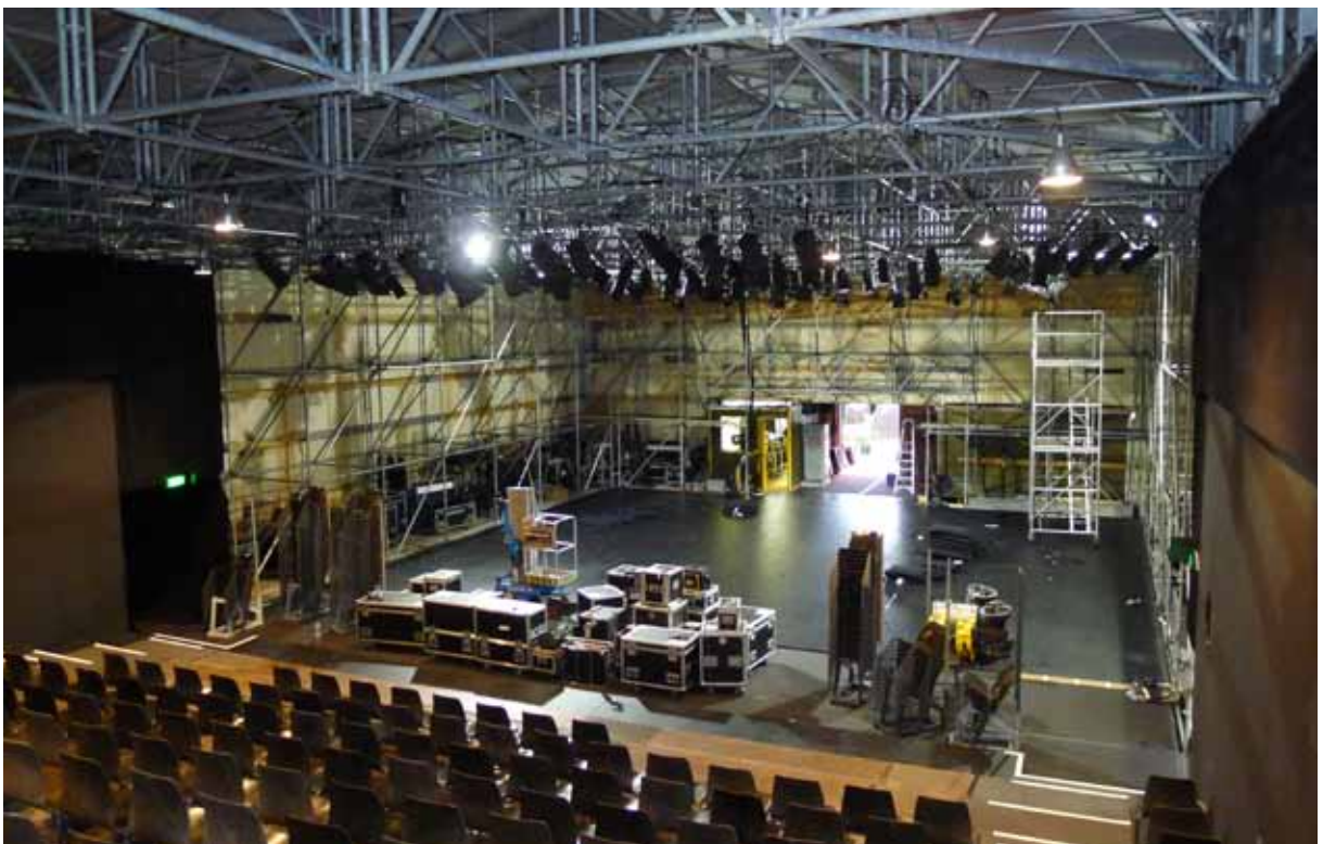
Technik Installation Nord am Tragwerk, Lagerflächen angrenzend Bühne zwischen Bühnentextil und Aussenhülle, Technikraum Container anschliessend zur Bühne
