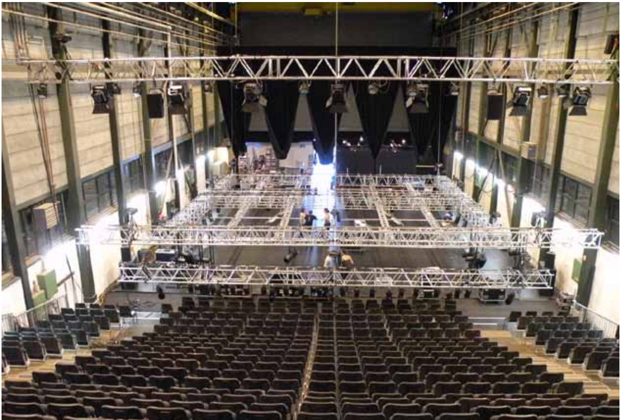
Umbau Werft, Theatertechnik an Alutraversen mit Kettenzügen
