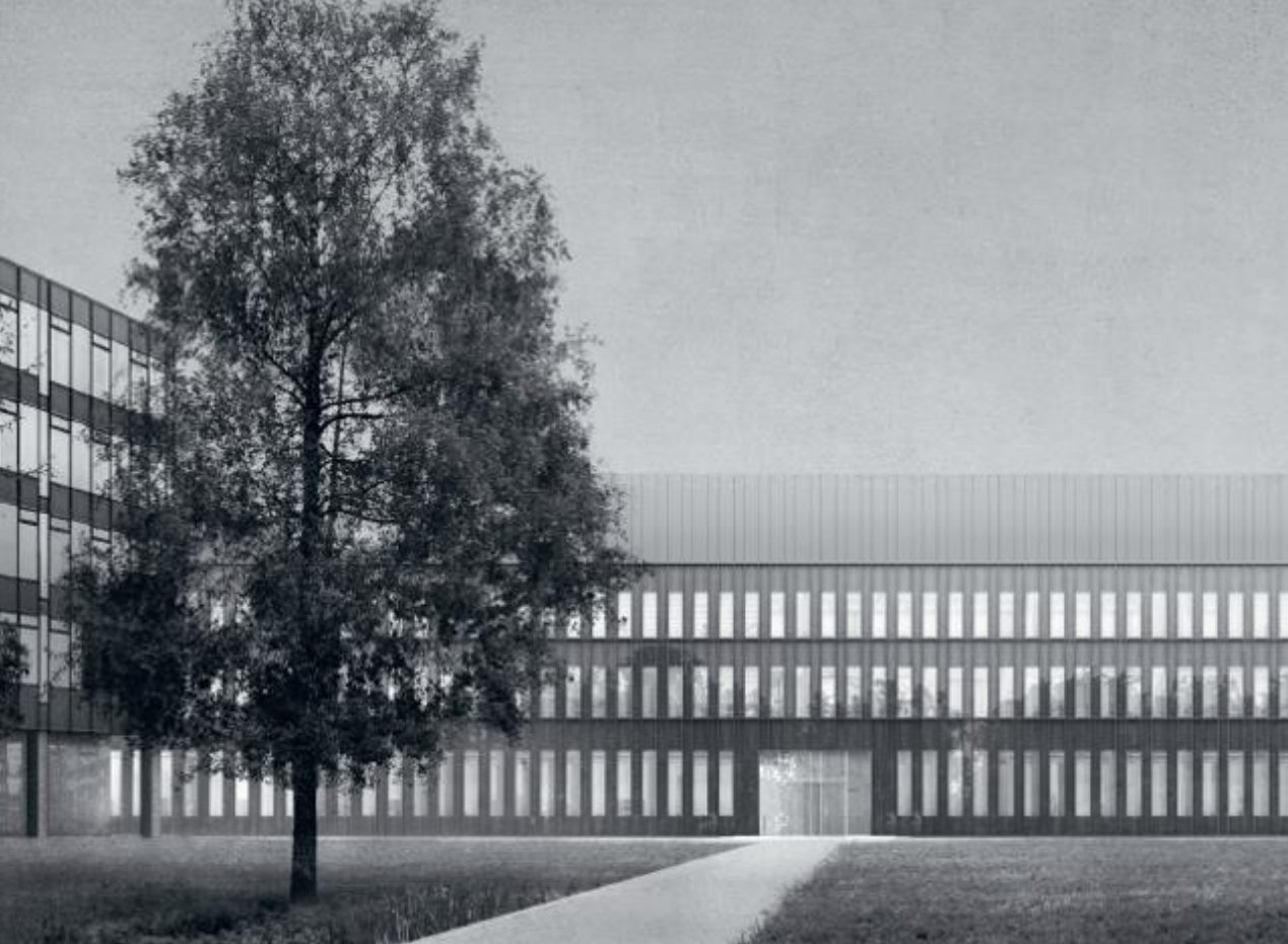
Neue Fassade aus Glas- und Fensterelementen
